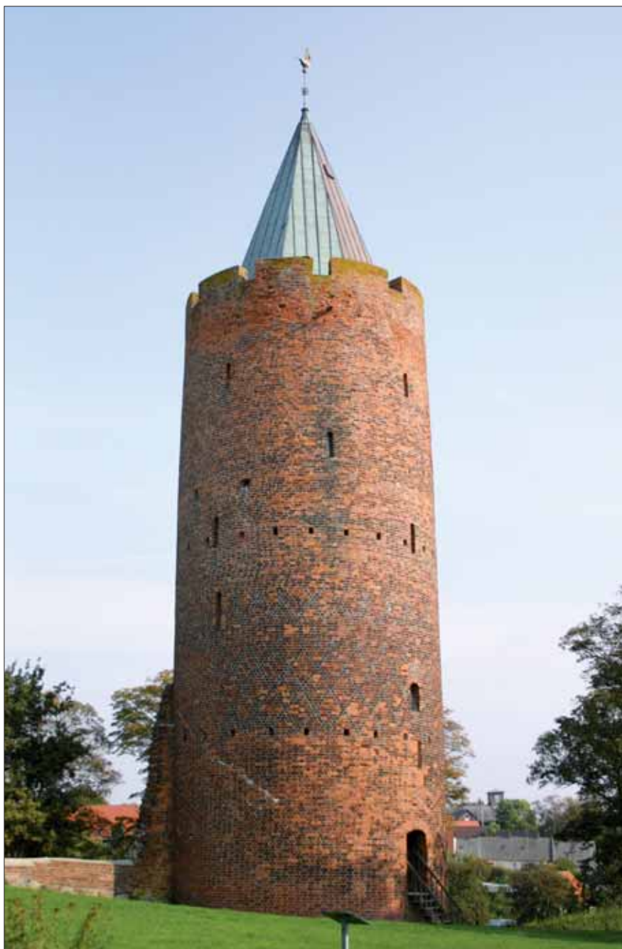
Fig. 2. Gåsetårnet blev bygget omkring 1365. Det er udsmykket med et rudemønster af overbrændte, sortsindrede sten
